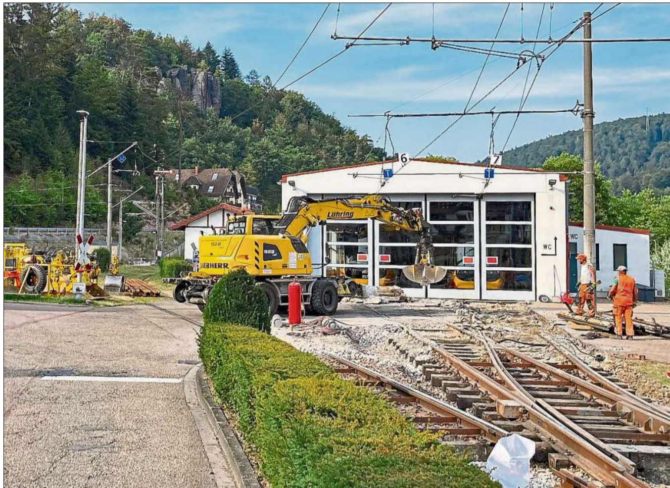
Derzeit ist der Bahnhof in Bad Herrenalb ohne Gleisanschluss wegen Austausch von Schienen und Gleisbett.
